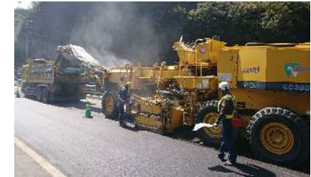
路上路盤再生工
