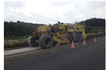
基層工・表層工
